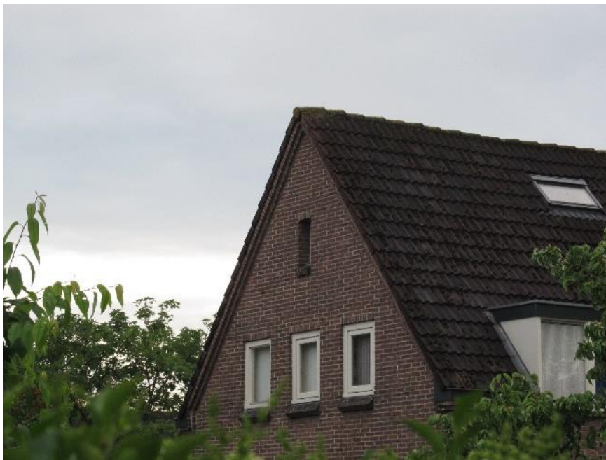
Foto 1 Detail kopgevel (nestplaats Gierzwaluw)
