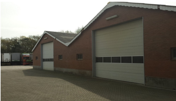
Transportbedrijf E. van den Brink, bestaande loodsen noordgevel
