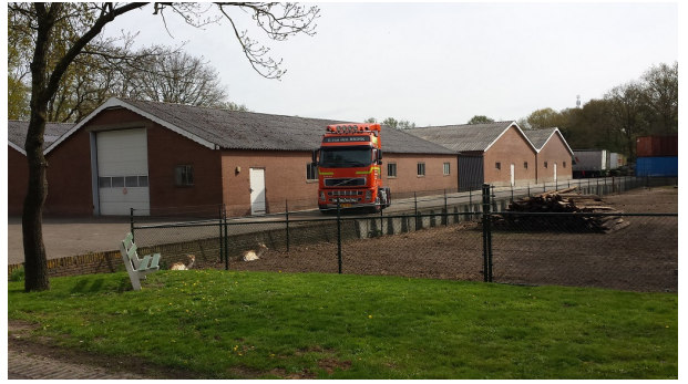
Transportbedrijf E. van den Brink, bestaande loodsen zuidgevel
