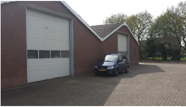
Transportbedrijf E. van den Brink; Bestaande loodsen westgevel
