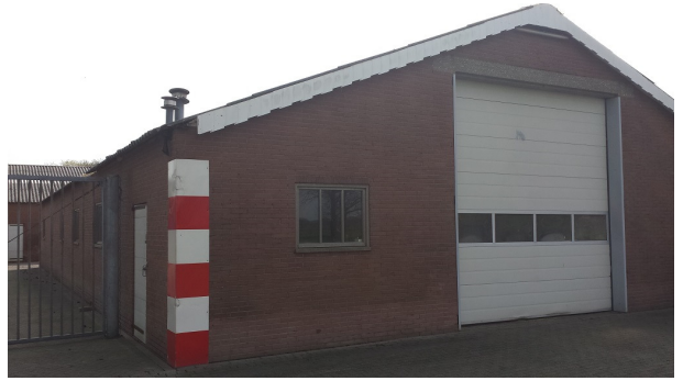
Transportbedrijf E. van den Brink; Bestaande loodsen westgevel
