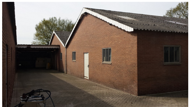
Transportbedrijf E. van den Brink; Bestaande loodsen noordgevel
