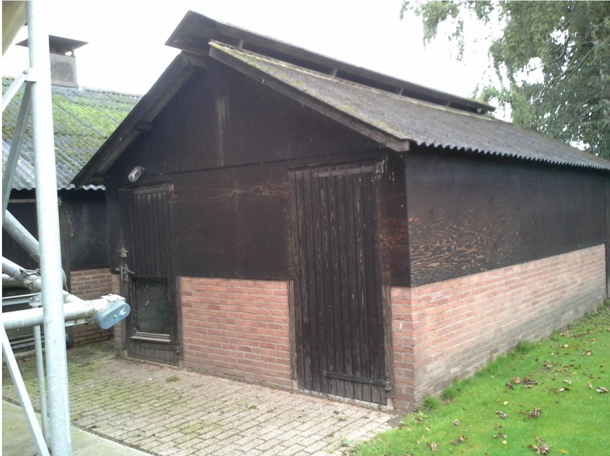
Fig. 2-3. Zuidoostzijde van de schuur.
