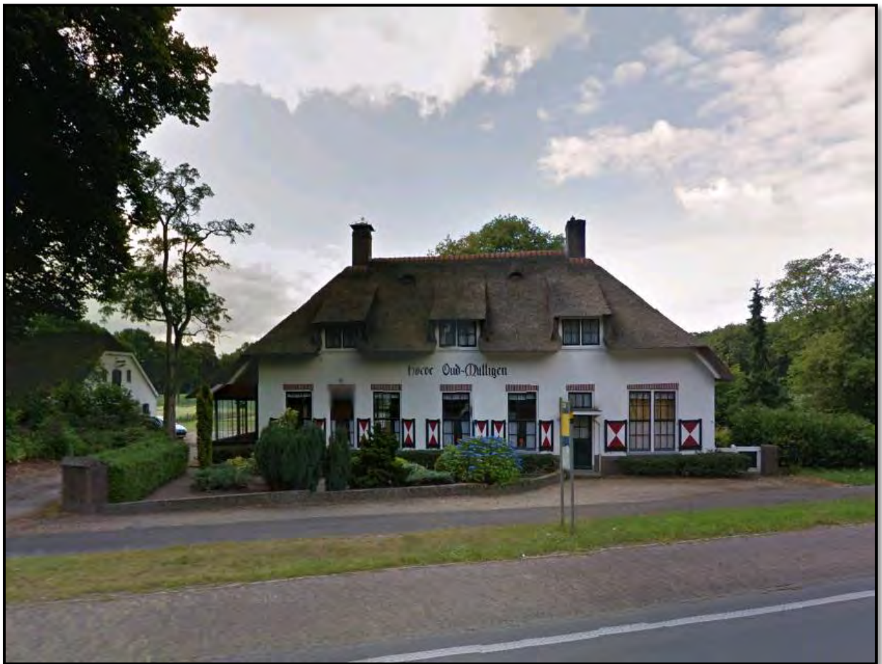
Figuur 1 - Foto bedrijfslocatie
