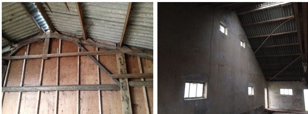
Figuur 3 De daken en muren van de te slopen opstallen zijn niet geschikt voor vleermuizen. Zowel de werktuigenberging (links) als de kalverenschuur (rechts) hebben een, niet geïsoleerd dak, van golfplaten (©Blom Ecologie).
