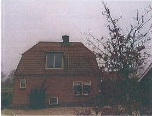
Foto 1: Woning (gebouw A)
