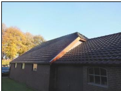
Figuur 3. Te slopen schuur.
