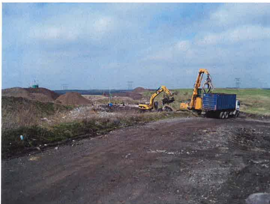
Figuur 5.1.2. Overzicht meetlocatie (serie 1) tijdens afgraven, omzetten en afvoeren
