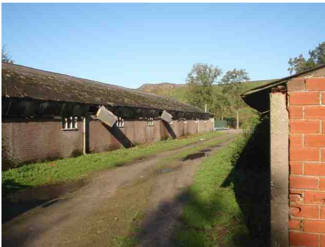
Wencopperweg 70, zicht op de te slopen varkensstallen.
