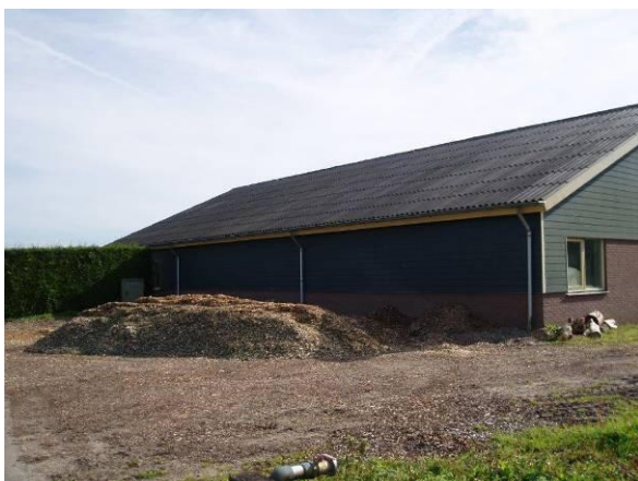
Foto 3: Zicht op de noordzijde van het bedrijfspand met opslag van houtsnippers
