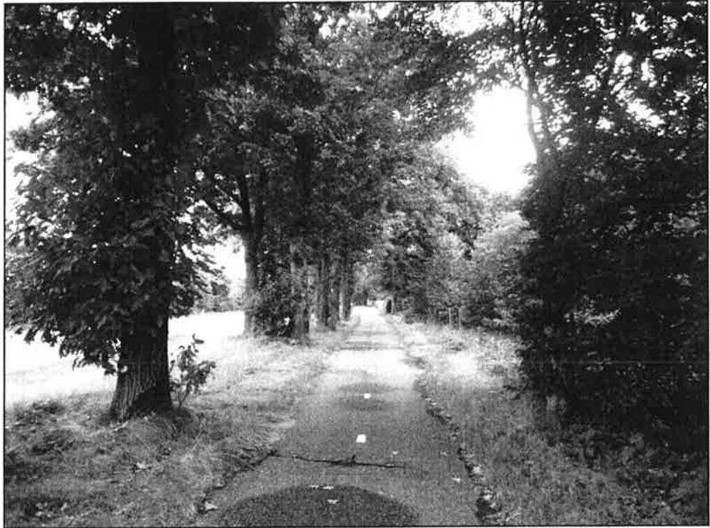
Figuur 2.4 Het bestaande fietspad waar het nieuwe fietspad op aansluit.
