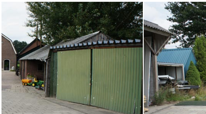
de te slopen bijgebouwen naast (boven) en aan de achterzijde van de woning
