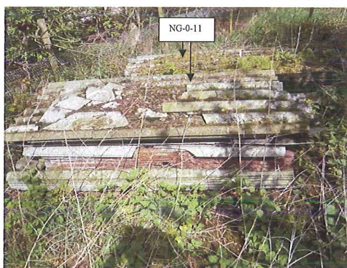
Foto 18: Twee stapels losstaande asbesthoudende golfplaat nabij shed 9 en 10.
