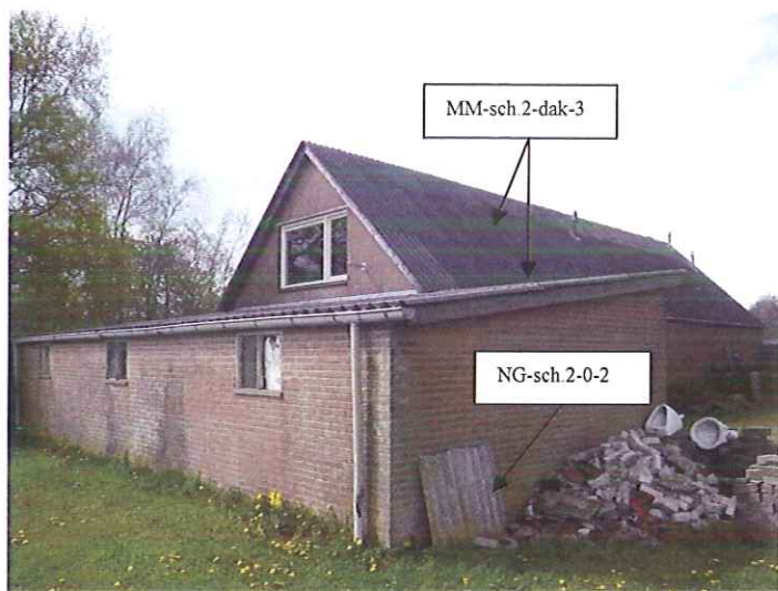
Foto 5: Geïnventarisierde schuur 2 met asbesthoudende golfplaat als dakbedekking vanuit zuidoostelijke richting gezien. (tevens losstaande golfplaat zichtbaar)
