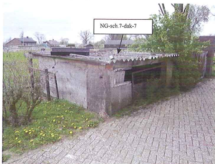
Foto 14: Geïnventarisierde schuur 7 met asbesthoudende golfplaat als dakbedekking vanuit zuidoostelijke richting gezien.
