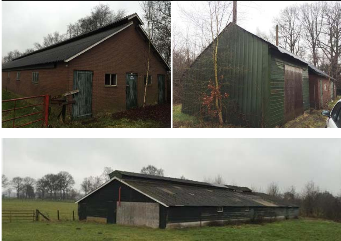
Figuur 1.2 De te slopen agrarische bedrijfsgebouwen.
