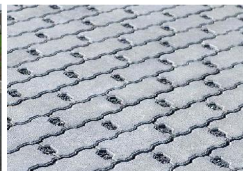
voorbeeld waterdoorlatende verharding
