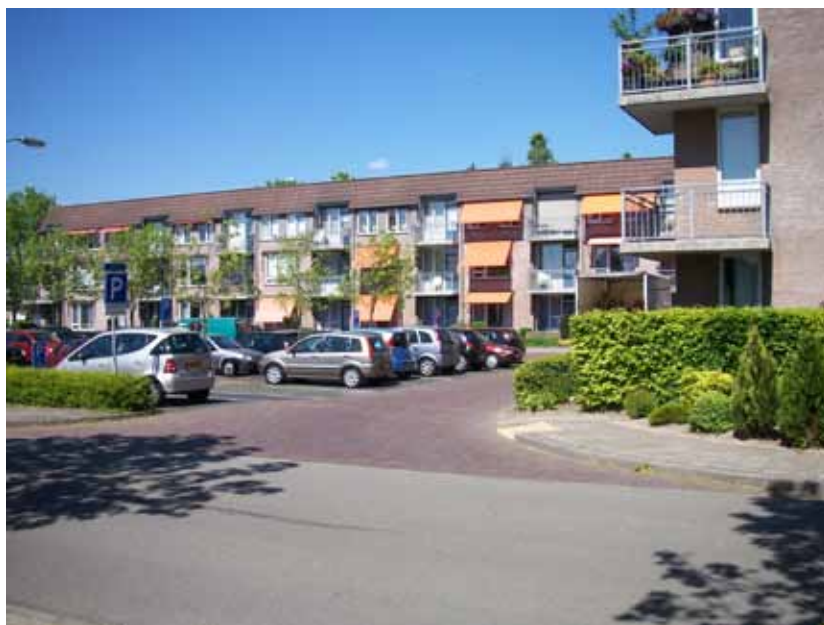
4 Achterdorp aan de Koterweg met entree
