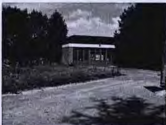
Foto 1: Loods (voormalige R.M.O.-garage) op braakliggende achterterrein.
