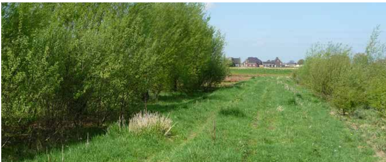
Een hogergelegen schouwpad maakt de beekzone voor onderhoud bereikbaar, is tevens de kering tussen het beek-wadisloot systeem en kan dienen als informeel wandelpad
