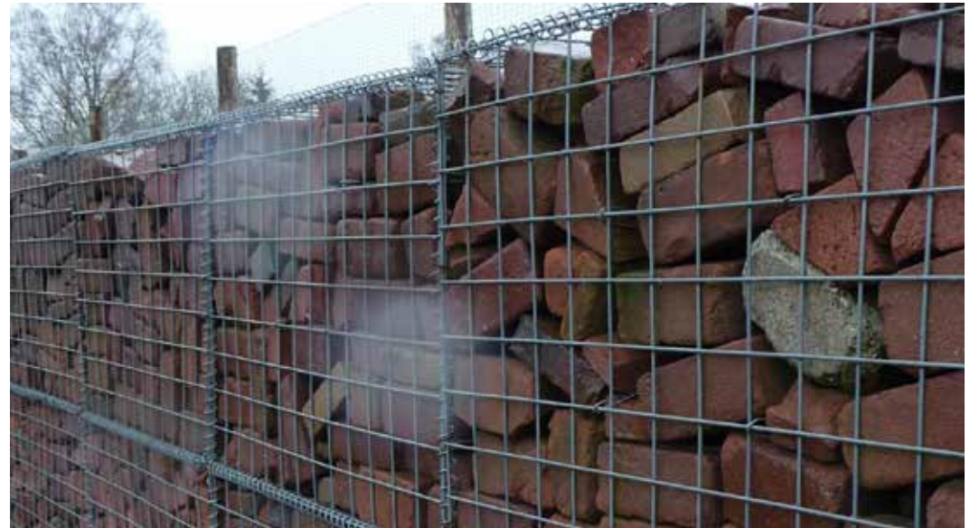
Schanskorven vullen met plaatselijke baksteen (te slopen opstanden)
