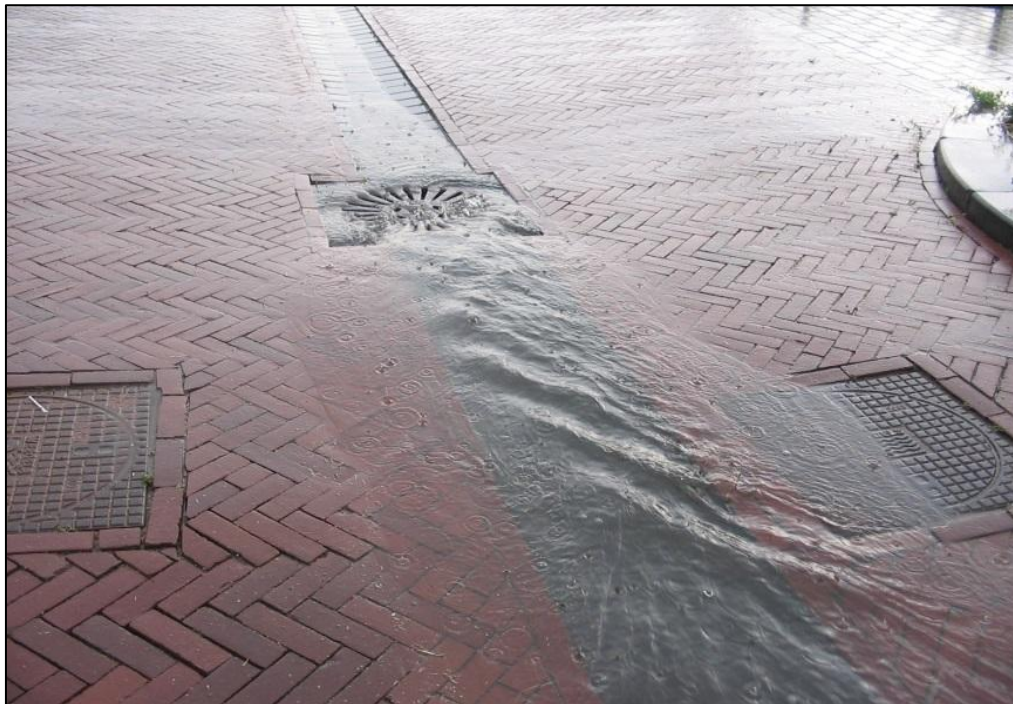
Foto 1 Voorbeeld van een goot overbelast door aanvoer van regenwater
