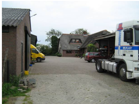
Foto 2: Erfoverzicht, ter plaatse van de gele bus is de asbest verdachte halfverharding
