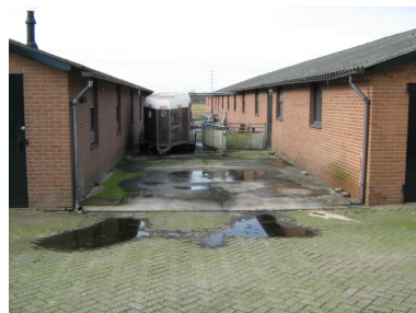
Foto 3: Betonplaat gierkelder
