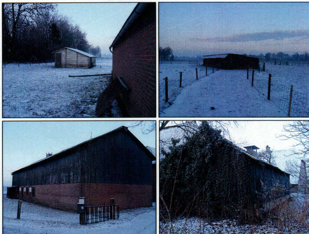
Foto 1 t/m 4. Buitenzijde van een aantal van de te slopen gebouwen bij huisnr 10.
