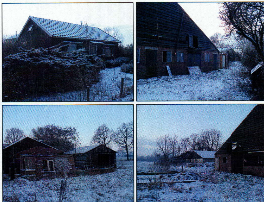
Foto 7 t/m 10. Buitenzijde van enkele van de te slopen gebouwen behorende bij huisnr 4.
