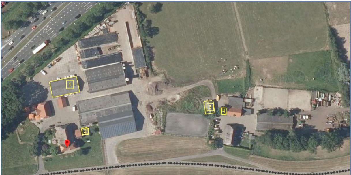
Locatiefoto 2 Luchtfoto met aanduiding te slopen gebouwen (in geel)
