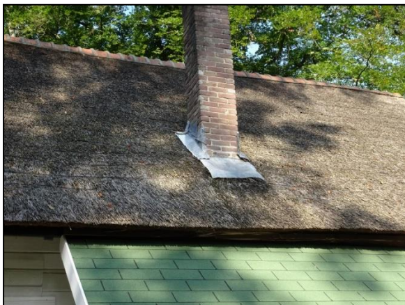
Figuur 11. Het lood rond de schoorsteen sluit strak aan op het rieten dak.
