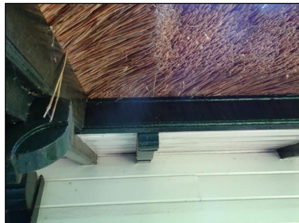
Figuur 12. Er zijn geen openingen aanwezig die toegang zouden kunnen bieden tot ruimtes onder het rieten dak.
