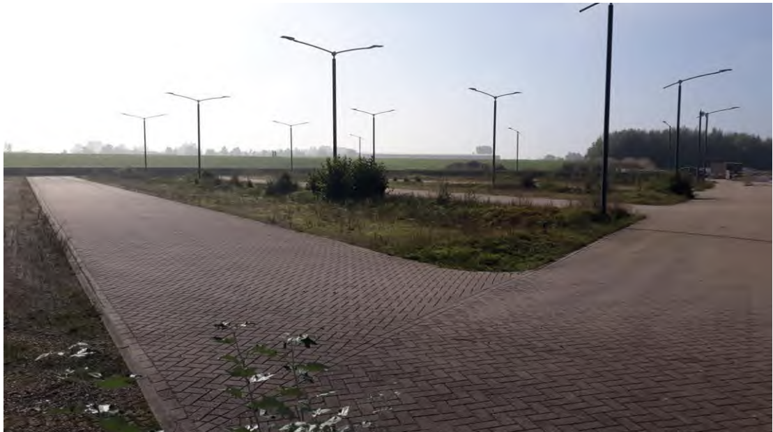
Huidige situatie parkeerterrein in westelijke richting (bron: Bluevest)
