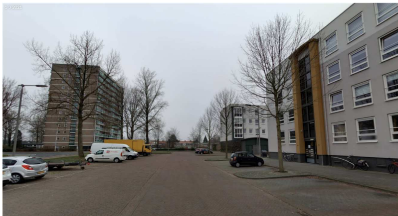
Figuur 2.6: huidige vormgeving Anemoonstraat (01-03-2021, Cyclomedia)
