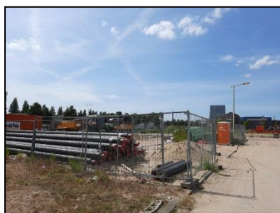
Figuur 3. Opslag van materialen op de onderzoekslocatie.
