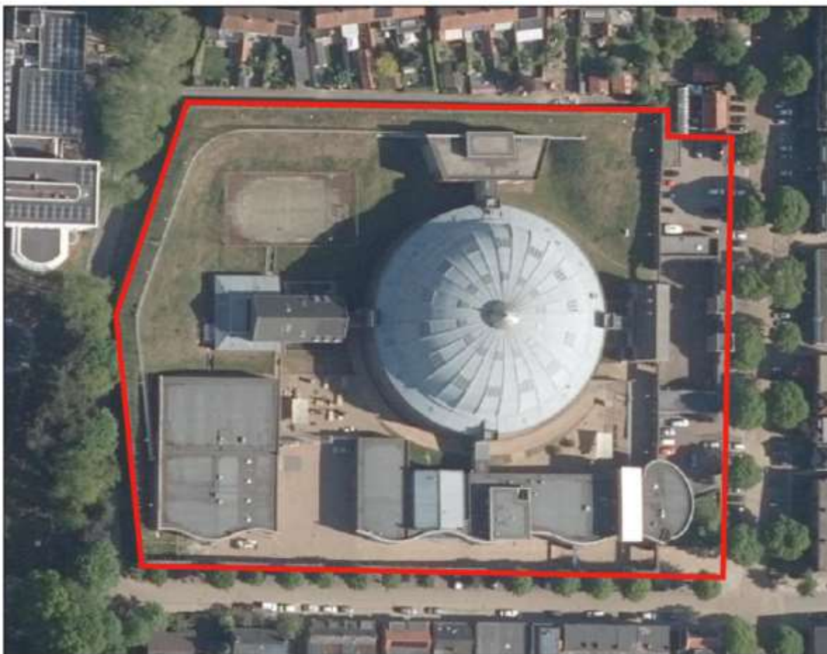
Afbeelding 2.1 Luchtfoto van het projectgebied (Bron: PDOK)
