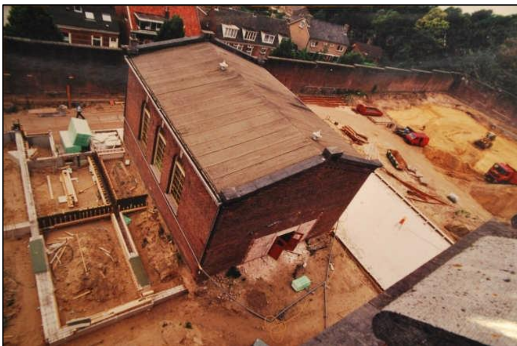
Afbeelding 6. Foto oude nieuwbouw genomen in zuidwestelijke richting. Vergraving ten behoeve van de aanleg van funderingsmuren en kelders.
