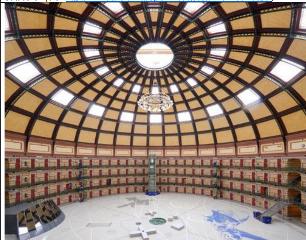
Binnen in de Koepel (bron http://www.transformatieplein.nl/object/arnhem-de-koepel )
