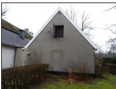
Figuur 6. Voorzijde van het bijgebouw.
