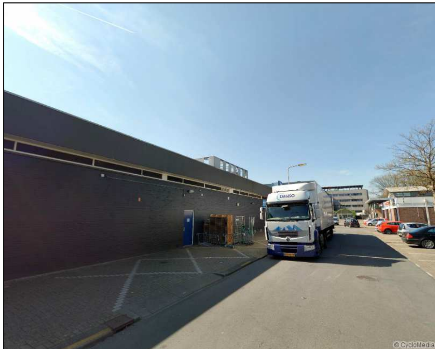
Figuur 2.6: Bevoorradig Albert Heijn in de huidige situatie (bron foto: Cyclomedia)
