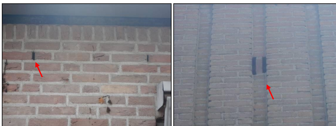
Figuur 7. Enkele toegangsmogelijkheden voor vleermuizen naar verblijfplaatsen in de spouw.
