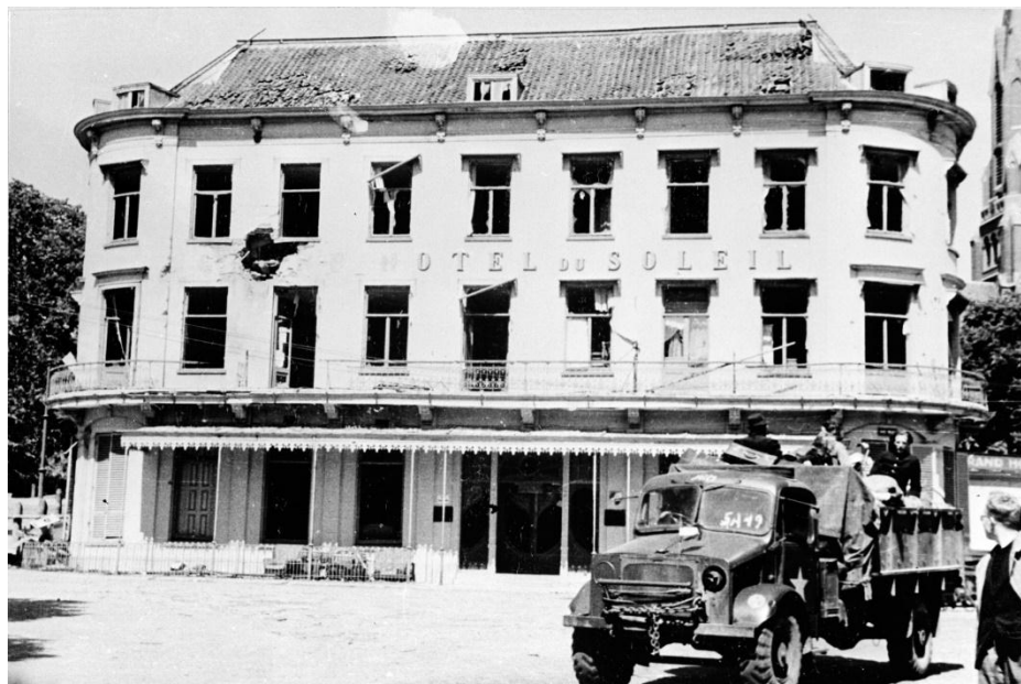
Figuur 2.8 De oorlogsschade aan hotel Du Soleil lijkt beperkt te zijn geweest. Ramen zijn gesneuveld, dakpannen kapot en er is in gat in de voorgevel geslagen. (Gelders Archief, fotograaf Nico Kramer).
