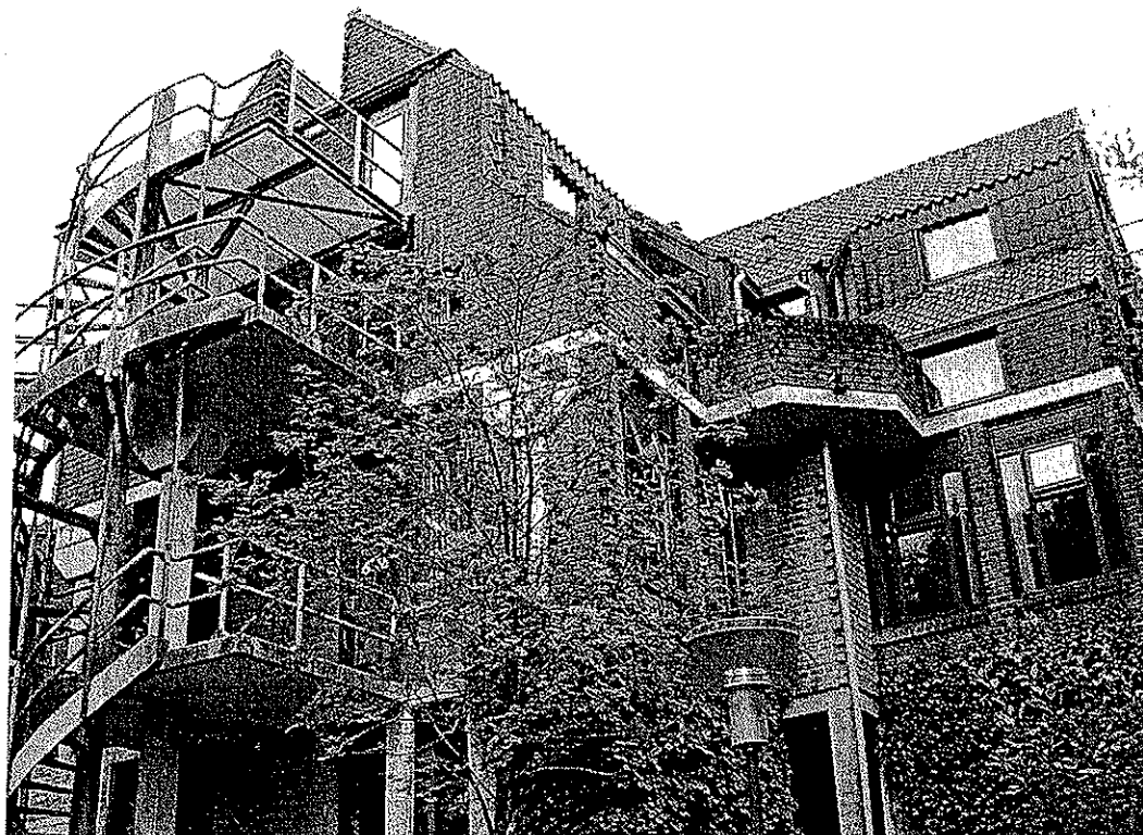
Figuur 7 Zicht op de gevelopbouw.
