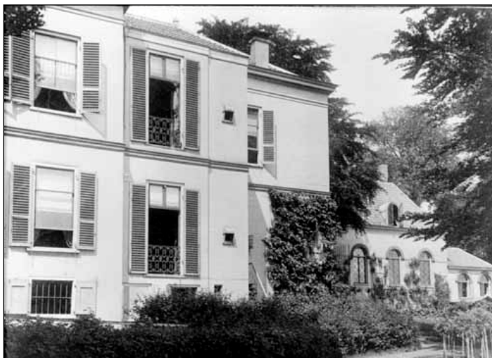
Figuur 18 – Links huis Klingelbeek (gezien vanaf de achterzijde). Rechts de rechterzijgevel van het koetshuis met aangrenzende orangerie. De foto is genomen voor de verbouwing van 1925, waarschijnlijk in de 19 de eeuw.
