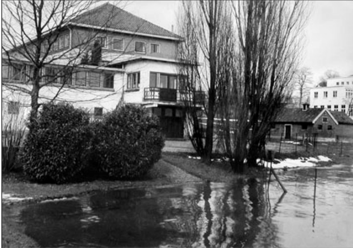
Figuur 22 – Verbindingsgang gezien vanaf de Rijnzijde, met op de achtergrond het koetsgebouw, waarvan de bovenste strook ongepleisterd is. [Geldersarchief]
