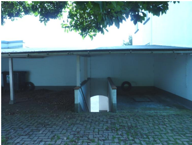
De aanbouw van een verbindingsgang in 1979 blokkeert het zicht op de Rijn.
