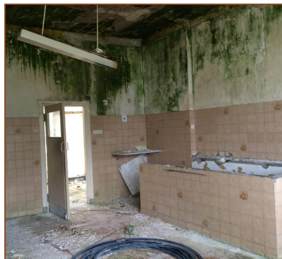
Afb. 3.5: Binnenzijde van de restanten van het bijgebouw.
