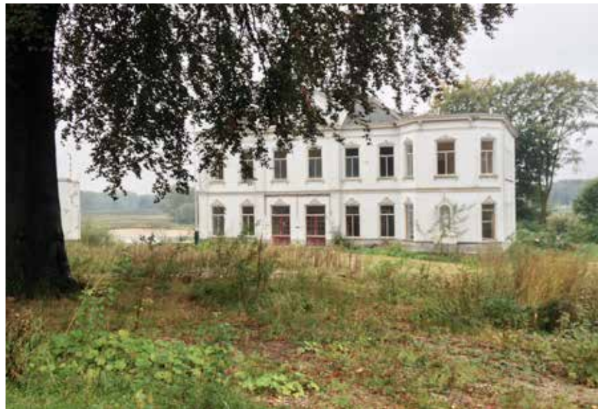
Voorzijde gevel villa redelijk intact
