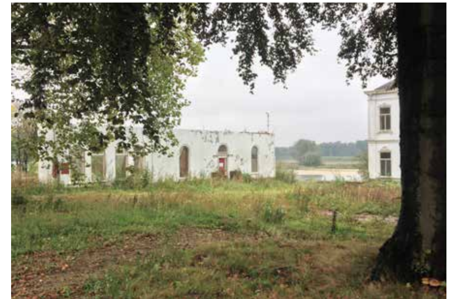
Gevelrestant enigszins intacte gevel links naast de villa.
