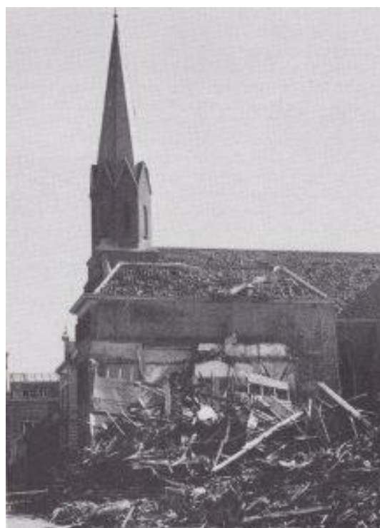
Figuur 17. De Oosterkerk na de Tweede Wereldoorlog, gezien vanuit het noorden ( https://gereformeerdekerken.info/2020/10/15/de-gereformeerde-kerk-te-arnhem-3/ )
