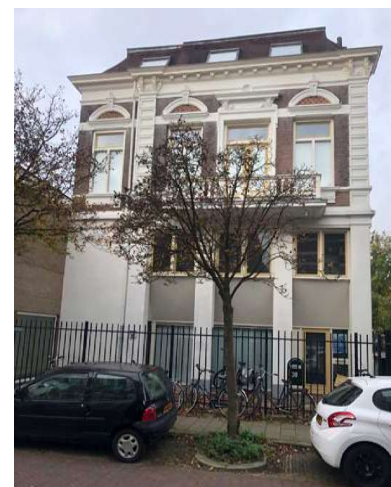
foto huidige gevel villa
