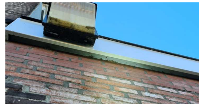
Figuur 10: Dakrand rondom bedrijfsgebouw
