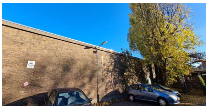
Figuur 6: Westkant van de opslagloods
