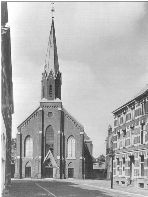
Figuur 1: De oosterkerk aan de Rietgrachtstraat 32, gefotografeerd vanuit de tegenoverliggende Prinsessestraat in volle glorie voor de sloop.
