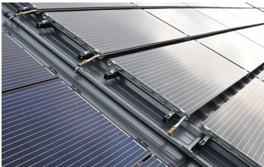
Figuur 3.5 | Voorbeeld PVT panelen, de thermische module is hier achter het PV paneel geplaatst.
