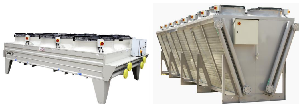
Figuur 3.7 | Voorbeeld droge koeler, het tafel model (links) en het V-model (rechts).
