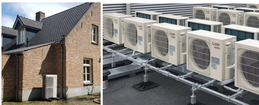
Figuur 3.6 | Voorbeeld buitenunit lucht-/waterwarmtepomp, enkele woning (links) of meerdere appartementen (rechts).
