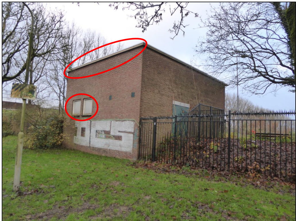
Impressie van (mogelijk) geschikte openingen voor dwergvleermuizen. Ruimte onder de dakrand en bij de ramen.
