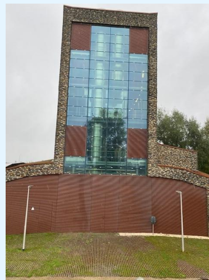
figuur 4: zuidgevel HWC
