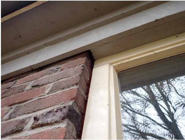
Foto 5: links, deklíjst een bovenzíjde van muur.
