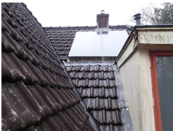
Foto 3: links, dak en dakkapel.
