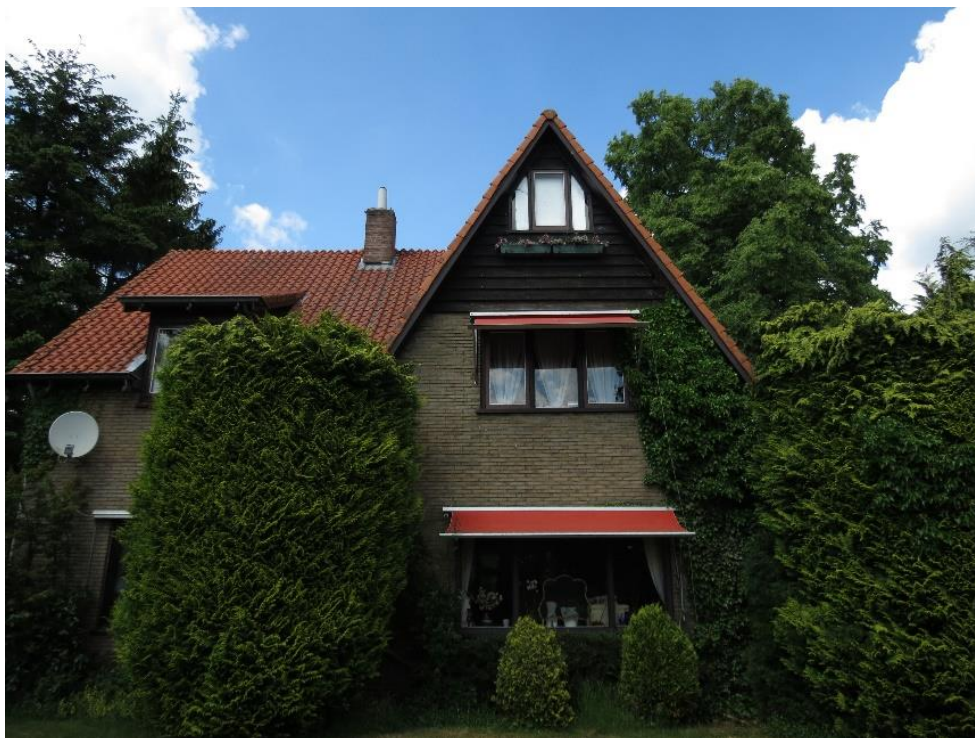
Woning aan de Elspeterweg 75 te Uddel
