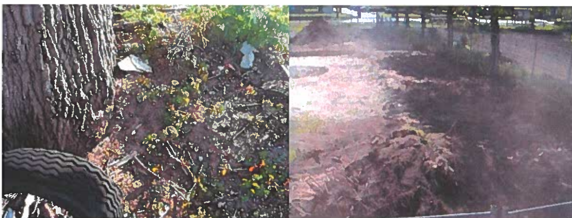
Foto 11: Asbesthoudend afval rond een grote boom bij gat 13
