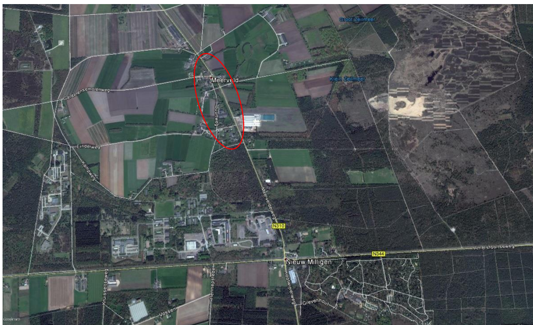
Figuur 1.1 Situatie ter plaatse (Bron: Google Earth)
